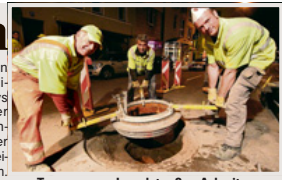
Tegernseer Landstraße: Arbeiter der Firma Haenlein bringen den neuen Schachtrahmen in Position
