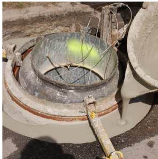
Der Spezialmörtel zieht innerhalb von Minuten trittfest an.
