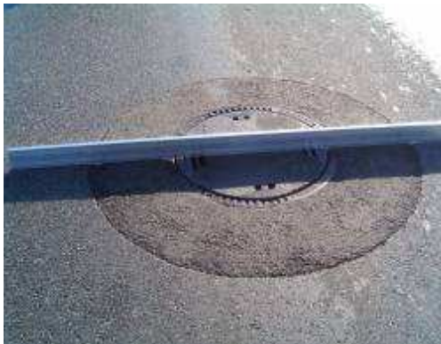
Nach Sanierung: kein Setzen des Schachts, auch nach Jahren!
