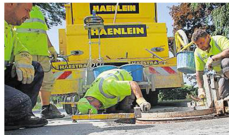
Die Arbeiter nivellieren die Höhe des Kanalschachts.
