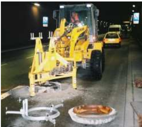
Budaplan: konischer Schachtrahmen mit Nivelliervorrichtung, Fräse in Aktion
