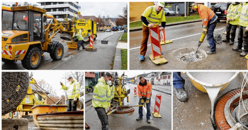
Claus-Dieter Haenlein und sein Team aus München bestücken die Ortsdurchfahrt von Königsbrunn im Zuge einer versuchsweisen Sanierung mit insgesamt elf neuen, konisch geformten Verbund-Kanaldeckeln. Vorbei ist damit das lästige Rumpeln und Klappern durch losgerüttelte alte Schachtrahmen – was vor allem auch die Anlieger freut. Weitere Fotos auf www.hz-online.de/bilder . Fotos: Sabrina Balzer
