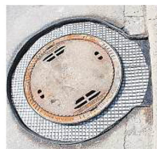
Eine Glasfaserschicht verbindet Beton und Asphalt miteinander.
