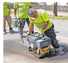
Letzter Arbeitsschritt: Der Asphalt wird verdichtet.
