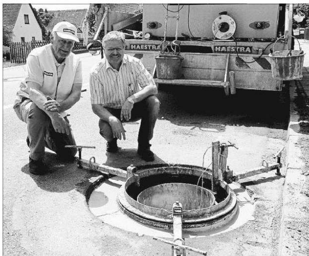
Firmenchef Klaus Dieter Haenlein und Bürgermeister Zeitler begutachten das Werk auf der St. Johanner Ortsdurchfahrt. Foto: Niesl
