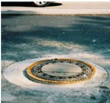
Budaplan: in Tragschicht vergossener, konischer Rahmen, Mittlerer Ring
