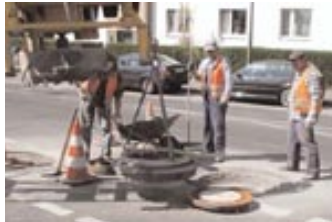
Abb 5: Einsetzen der neuen Abdeckung
