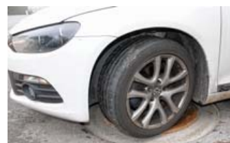
Zwei Stunden nach Einbau ist der neue Kanaldeckel befahrbar – hier fehlt allerdings noch die letzte Asphaltschicht.
