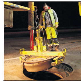
Der alte Rahmen ist ausgefräst. Die konischen Wände im Boden sind zu erkennen.
