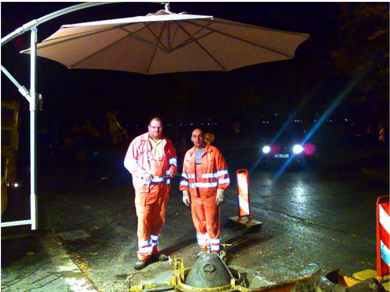
Nächtliche Schachtrahmensanierung mit Budaplan in einer vielbefahrenen Strasse
