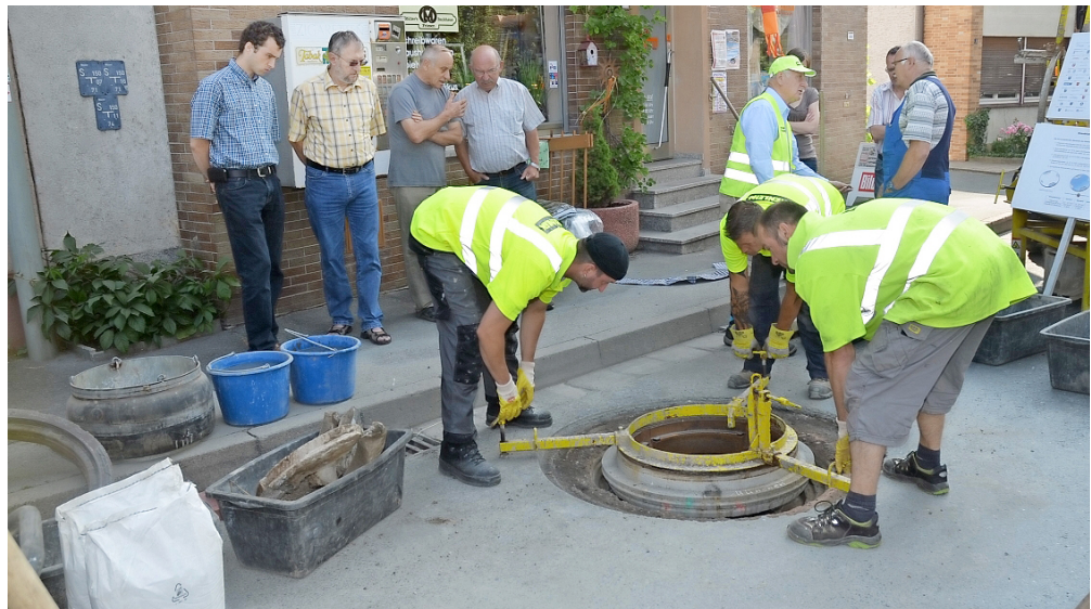
Am gestrigen Montag kam es zu Verkehrsbehinderungen auf der B 85 in Weißenbrunn und Kronach, weil dort ein neues Kanaldeckelsystem installiert wurde, das der Lärmbelästigung zu Leibe rückt. Das Bild entstand in der Ortsdurchfahrt Weißenbrunn beim Einsetzen des konischen Kanaldeckelsystems.
