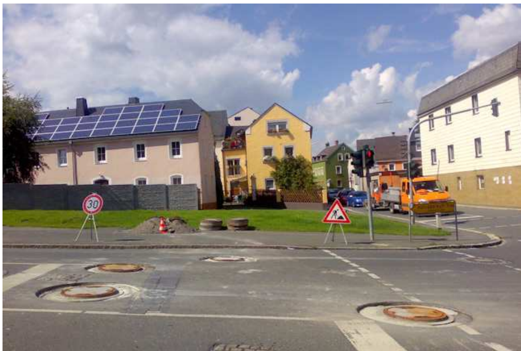
Konische Schachtrahmen, bereits mit ombran SVG vergossen, in Erwartung der Asphaltierer
