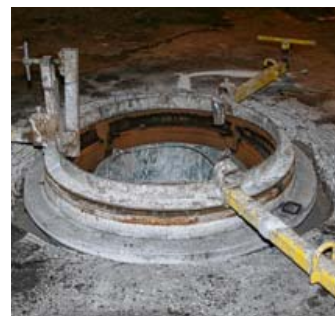
Eine Schachtdeckel-Einfassung wird in die sich nach oben öffnende Fräsung eingebaut.
