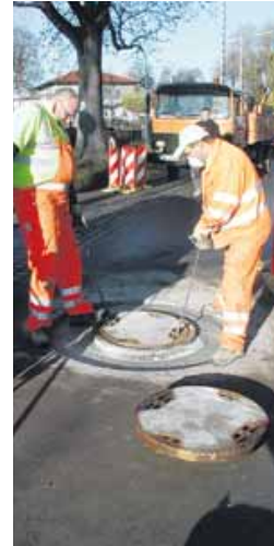
Konische Schachtabdeckungen werden seit gestern auf der Staatsstraße in Schondorf, Utting, Riederau und Dießen eingebaut. Sie sollen länger halten als bisherige konventionelle Bauweisen.
