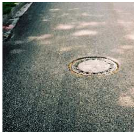
Das Ergebnis: Setzungsfreier Schachtrahmen
