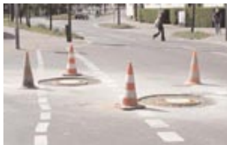
Abb. 6: Eingegossene neue Abdeckungen ohne Deckschicht aus Guss-Asphalt
