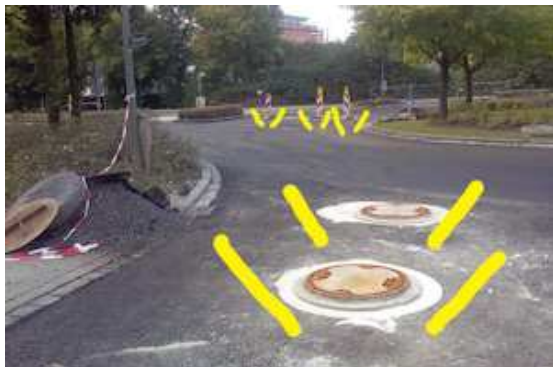
Konische Budaplan mit Kleeblattdeckel nach Einbau in die erneuerte Tragschicht
