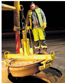
Der alte Rahmen ist ausgefräst. Die konischen Wände im Boden sind zu erkennen.
