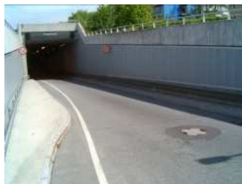
Die Kleeblattform des Deckels weist auf das konische System Buderus Budaplan.
