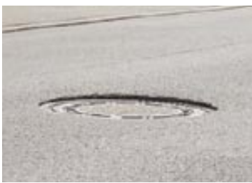
Abb 1: Abgesackte Schachtabdeckung
