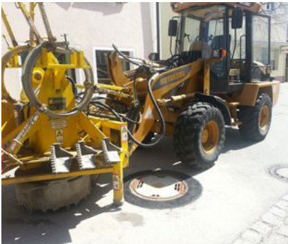
BUDAPLAN® schlüsselfertig eingebaut
