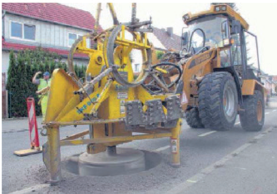
Kanaldeckelsanierung auf Häfler Straßen.
