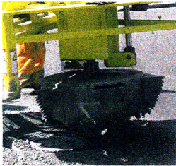
Mit der Fräse wurde der Rahmen freigelegt.
