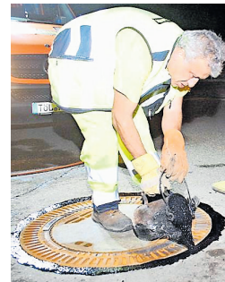
Die Heißvergussmasse, die zum Abschluss aufgetragen wird, stammt aus England.
