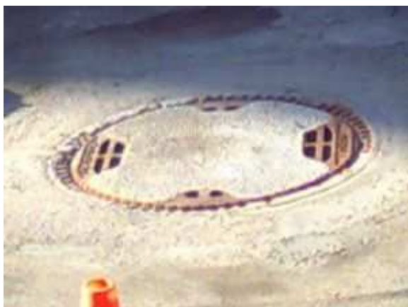
Der weltweit erste Konische Schachtrahmen 2008 wurde am 8. Januar eingebaut.
