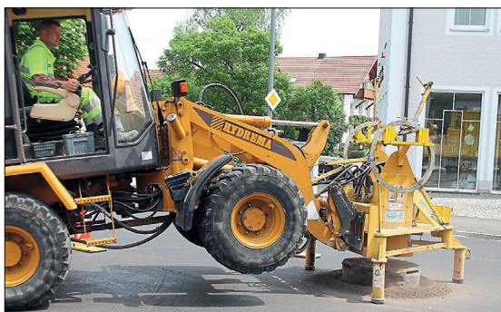
Die Firma Haenlein hat sich auf den Einbau von konischen Schachtdeckeln spezialisiert und ihre Gerätschaften entsprechend umgerüstet.
