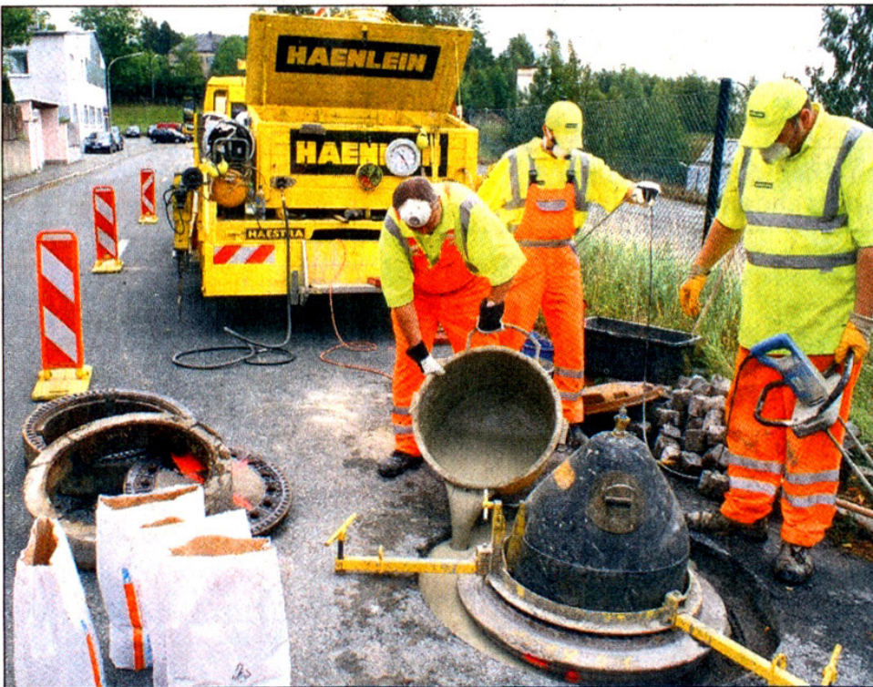
Arbeiter einer Spezialfirma sind seit Donnerstag dabei, die Kanaldeckel wieder anzuheben.
