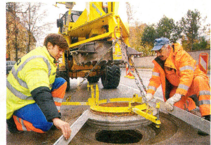
Einbau des Badewannen-Stöpsels für die Straße: Ludwig Haenlein (r.) und Duran Vural mit der neuen Gulli-Fassung. FOTO: JS
