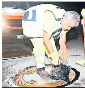
Die Heißvergussmasse, die zum Abschluss aufgetragen wird, stammt aus England.
