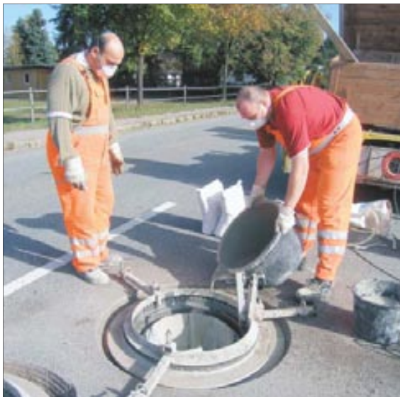
In den Zwischenraum wird Spezialmörtel gefüllt, er muss nach dem Abhärten Kälte und Streusalz aushalten.
