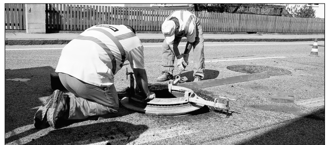
Claus-Dieter Haenlein erklärt die Vorzüge seines konischen Gullydeckels. – Die Mitarbeiter bringen den neuen Kanalverschluss in Position.
