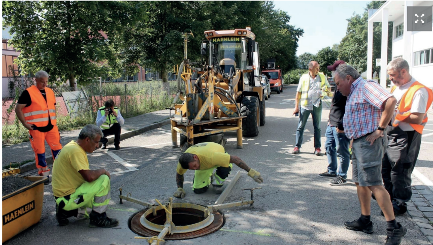
Passgenau wird der neue Schachtring auf die bestehende Einstiegs Luke gesetzt. © DC-X
