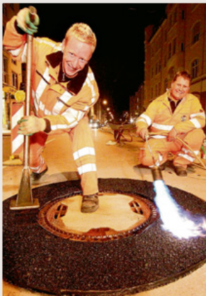
Frisch geteert - und der Flüster-Gully ist fertig
