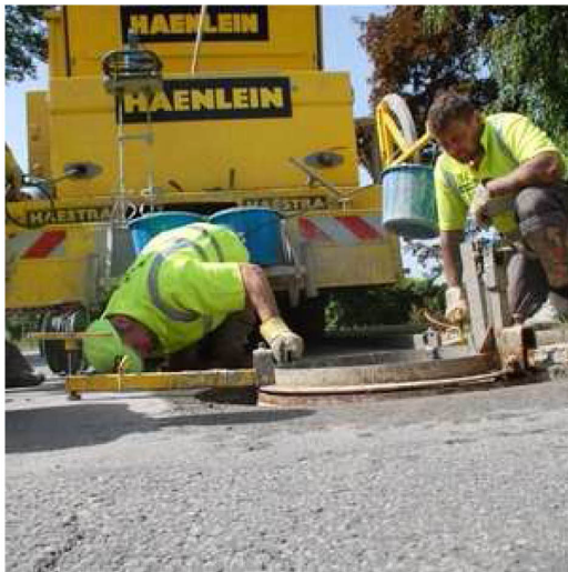
Die Arbeiter nivellieren die Höhe des Kanalschachts. Fotos: Neumaier
