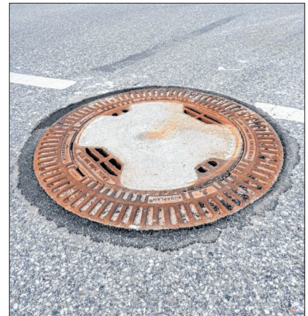
Fertig: Bereits am frühen Mittwochmorgen waren die Schachtdeckel fertig.
