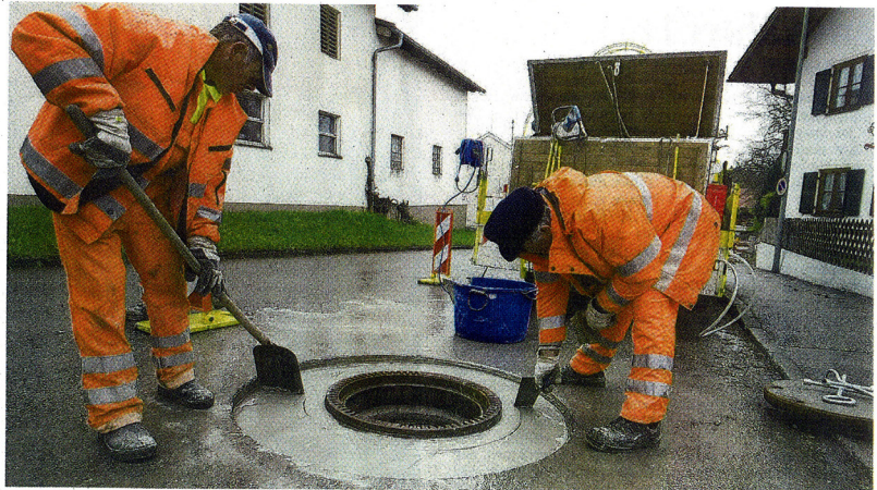
Die neuen Abdeckungen sind in dieser Woche in die Etterschlager Straße eingesetzt worden.
