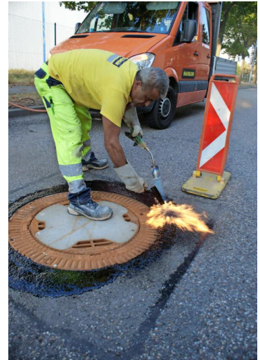
Am Ende hilft ein Flammenwerfer, die abdichtende Bitumenmasse mit Schacht und Straßenkörper zu verbinden.
