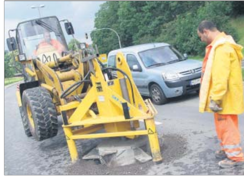
Die alten Kanaldeckel werden ausgefräst ...
