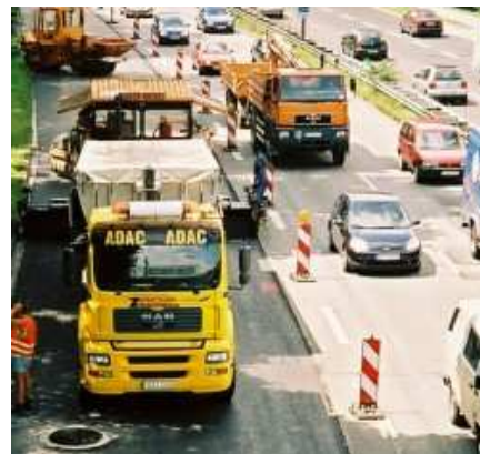
Aufbringen der Verschleißschicht bei starkem Verkehr
