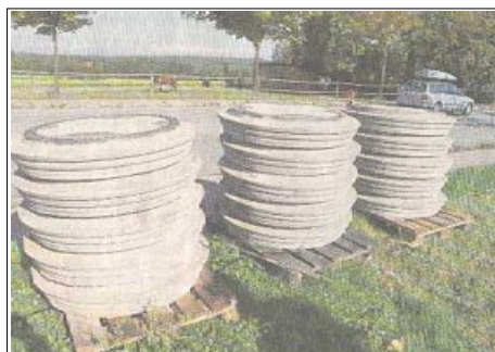
...und die neuartigen Kanaldeckel werden dann passgenau in den Schacht gesetzt.
