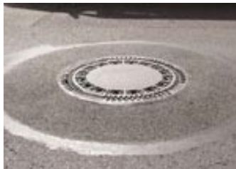
Abb. 7: Neue Abdeckung mit fertiger Deckschicht
