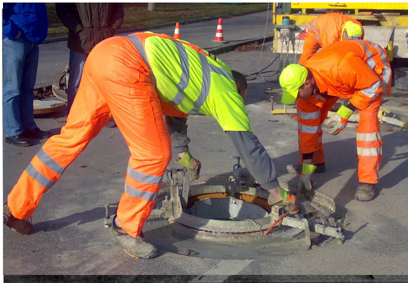
Im Auftrag des staatlichen Bauamtes München und des Abwasserzweckverbandes Unterschleißheim sind in der Landshuter Straße 40 Kanaldeckel ausgetauscht worden.
