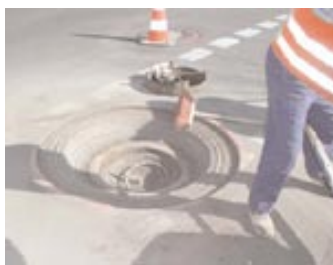
Abb 4: Ausgefräste Öffnung für Schachtabdeckung
