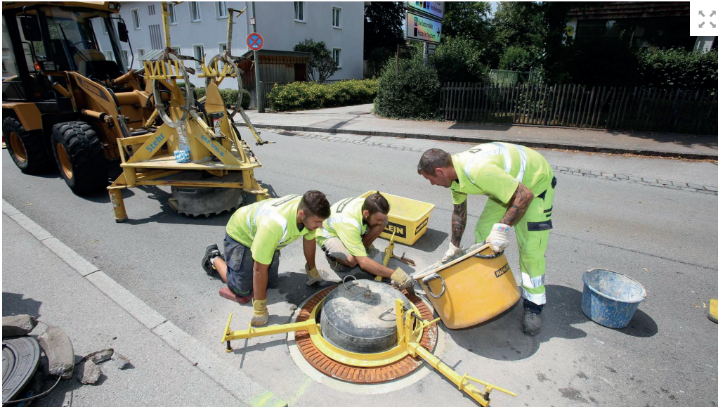
Da klappert nichts mehr: Unter anderem in der Jahnstraße gibt es jetzt die neuen Gully-Deckel. © Pröhl
