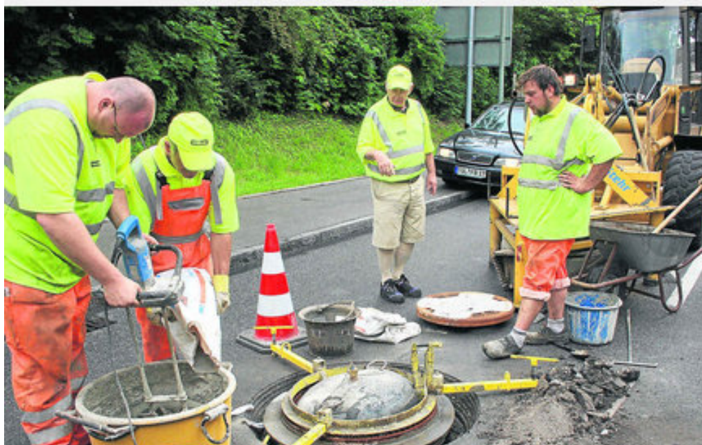
Neue Kanaldeckel auf der B11 sollen die Lärmbelastungen reduzieren. Foto: Hermsdorf
