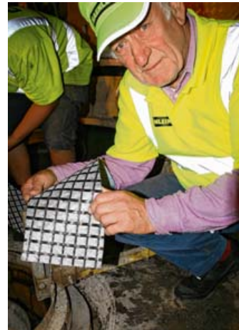
Eine Glasfasermatte, die Claus-Dieter Haenlein zeigt, soll noch mehr Tragfestigkeit garantieren. BILDER: DIETERLE-JÖCHLE
