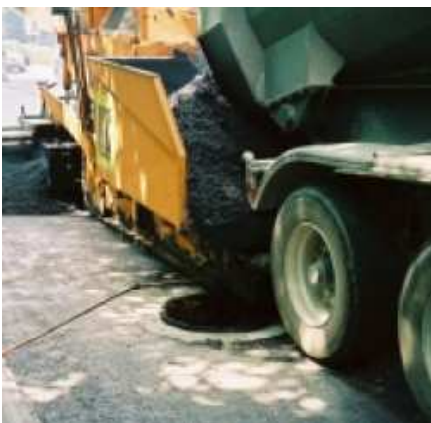
Einbau der Verschleißschicht
