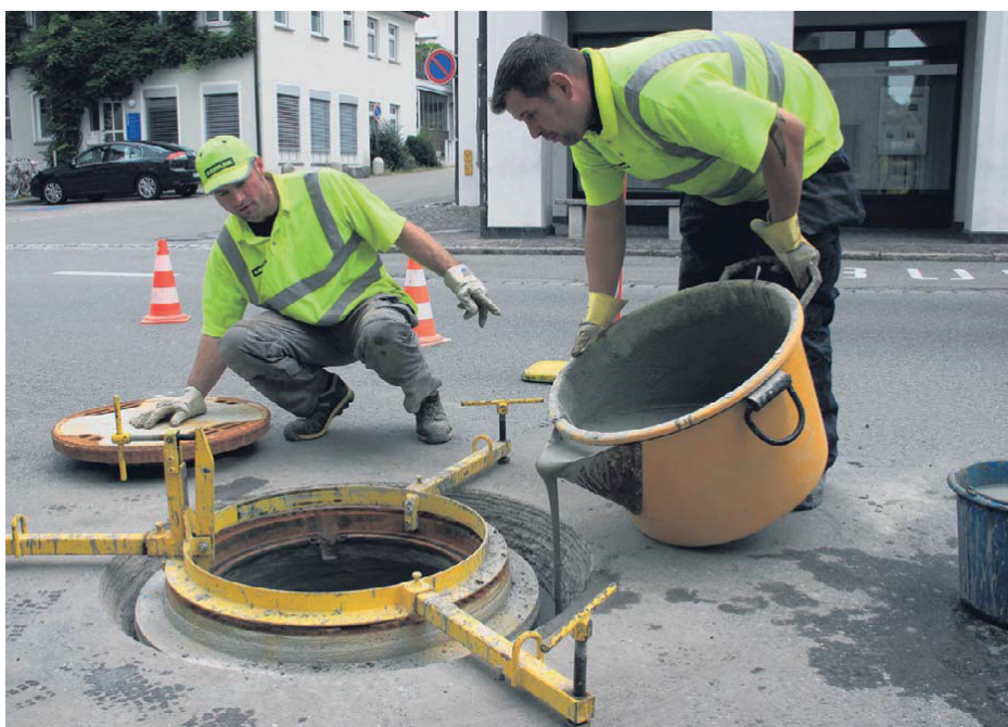
Hightech-Schachtdeckel: Die konische Form des ausgefrästen Loches und des Deckels (unter der gelben Halterung) nehmen den Druck von der darunter liegenden Fuge.
