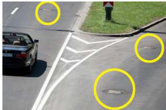
Konische Budaplan mit Kleeblattdeckel nach Fertigstellung der Verschleißschicht
