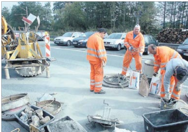
Unweit der Kronacher Südbücke wurden am Mittwoch erstmals die „konischen Schachtrahmen“ von Mitarbeitern einer Firma aus München in die Fahrbahn der Bundesstraße 85 eingebaut.
