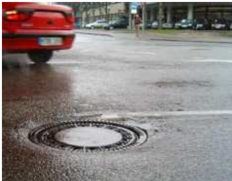
Vorher: Das gewohnte Schadensbild, Setzung des Schachtrahmens.
