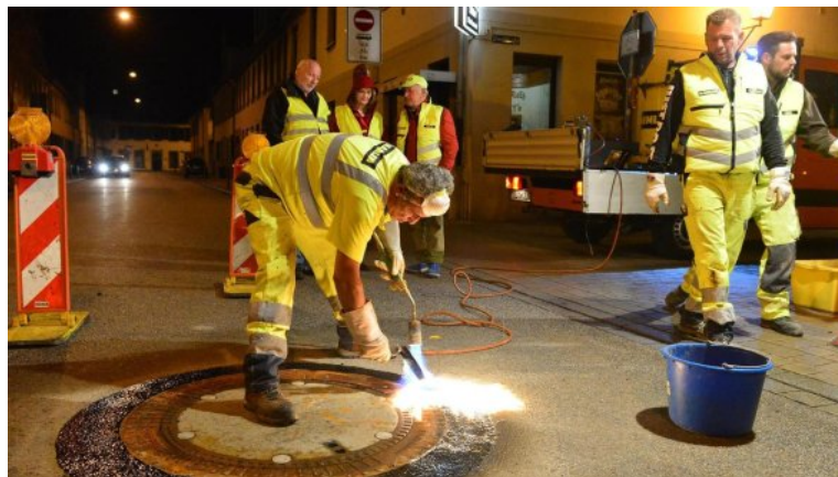
Drei neue Schachtabdeckungen sind während einer Nachtaktion im Kreuzungsbereich Goethe-/Paulistraße eingebaut worden. Zuletzt kommt noch Asphalt drüber - und fertig.
