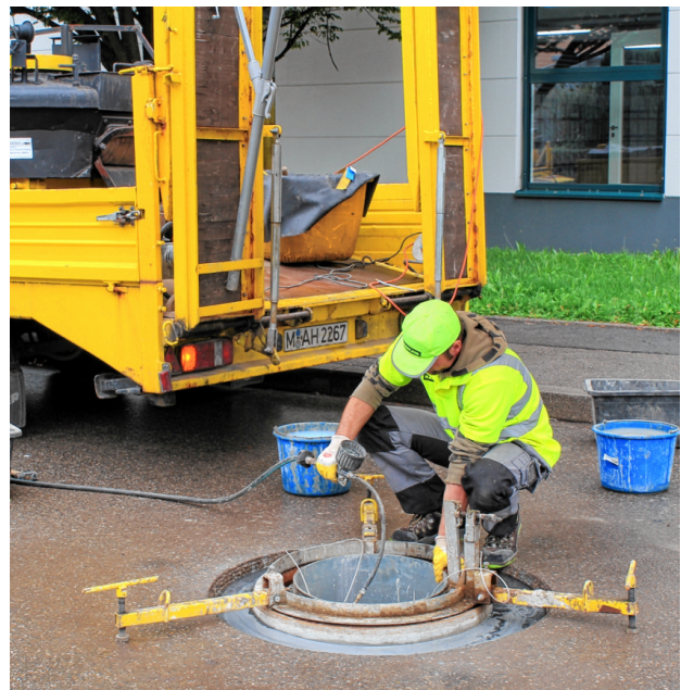
Die Kanaldeckel in der Flurstraße wurden saniert. FOTO HOFFMANN
