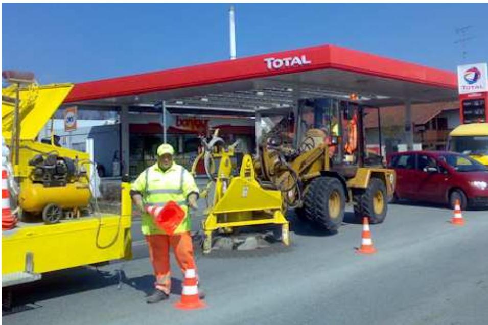
In Plattling bei der Fräsarbeit
