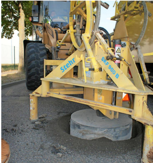
Start des Umbaus: Eine Spezialfräse bohrt die konische Form in den Straßenkörper. In wenigen Minuten ist das schräg verlaufende Loch entstanden.
