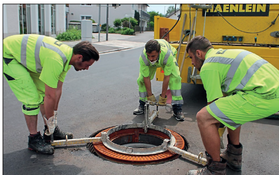
Auf den Millimeter genau kann der Schachtdeckel eingesetzt und der Zwischenraum anschließend ausgegossen werden.
