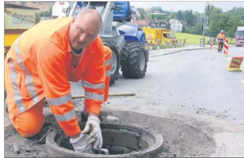
... und durch einen kegelförmigen Schachtrahmen ersetzt
