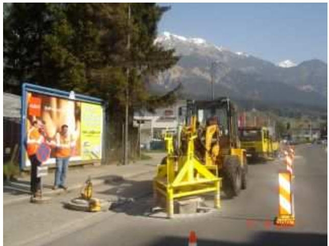
Innsbruck: Arbeiten am "Langen Weg".
