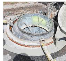
Der Spezialmörtel zieht innerhalb von Minuten trittfest an.
