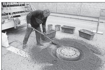
Damit der neue Gullydeckel in den Boden eingepasst werden kann, wurde dieser mit einer Fräse mit schrägen Flügeln abgetragen. (Fotos: bot)
