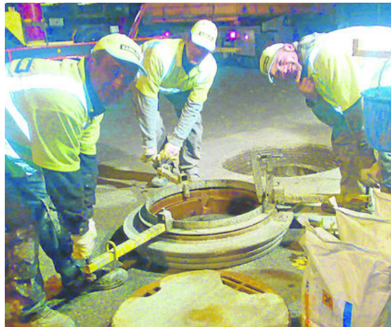
In der Nacht zum Samstag setzten Mesut Aksu, Matthias Hochstetter und Thomas Hochstetter (v.li.) von der Firma Haenlein die konischen Schachtrahmen in der Staatsstraße ein. FOTO: FKN
