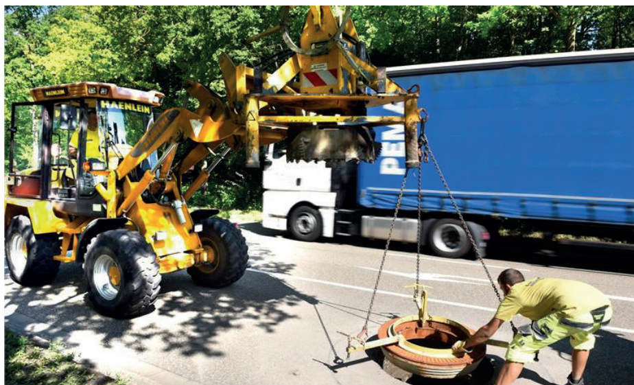
Das ging schnell: In der Herbert-Quandt-Allee wurden die Gullydeckel an einem Tag erneuert. Foto: TINO LEX
