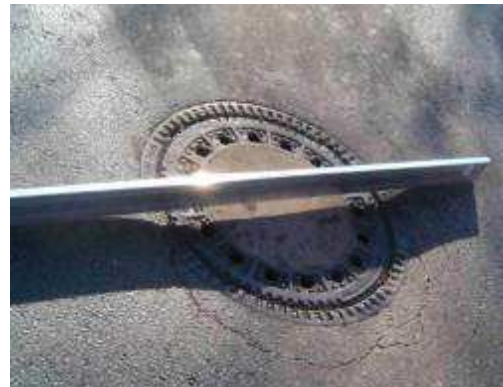
Vor Sanierung: Das gewohnte Schadensbild, Belastung von Fahrwerk und Fahrers Rücken.
