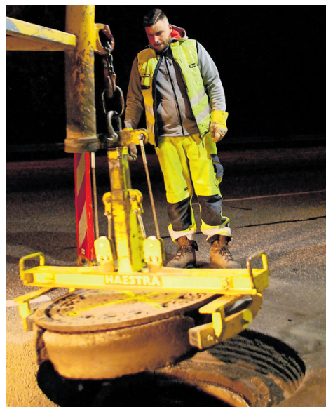
Der alte Rahmen ist ausgefräst. Die konischen Wände im Boden sind zu erkennen.
