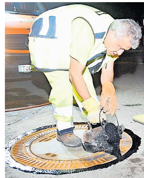
Die Heißvergussmasse, die zum Abschluss aufgetragen wird, stammt aus England.
