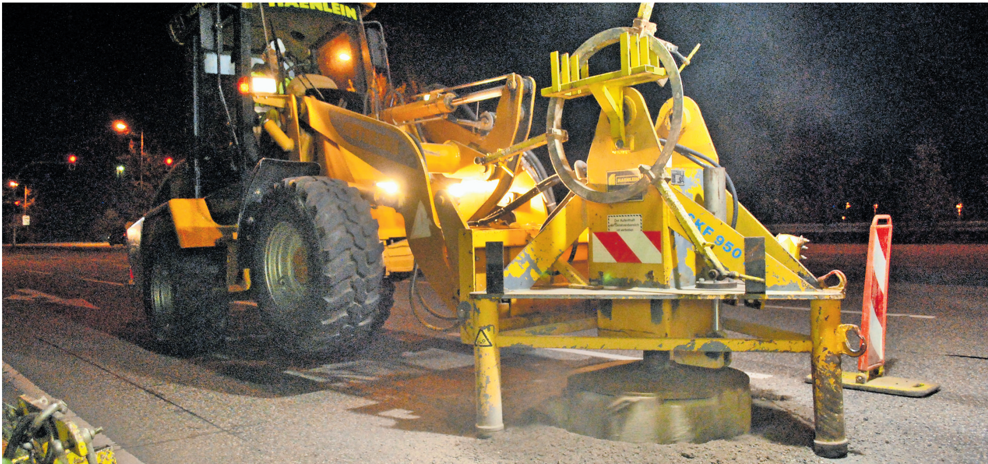
Die Fräse wird exakt über dem bisherigen Gullydeckel positioniert. Nach wenigen Minuten hat sie sich rundherum in die Fahrbahn gegraben.
